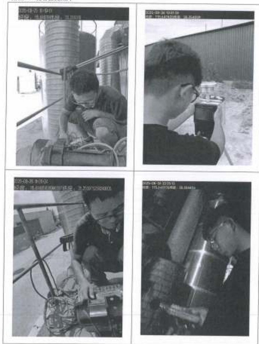
附图 3: 现场检测照片
